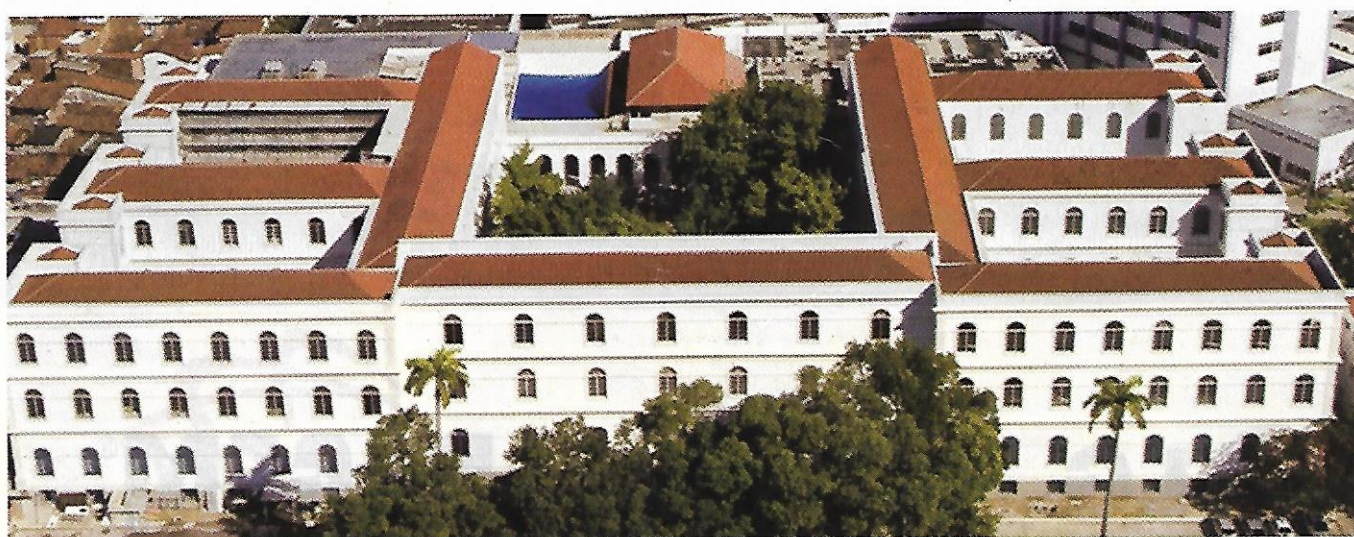
Restaurado, Hospital Pedro II passa a ser o maior complexo hospitalar do N/NE
